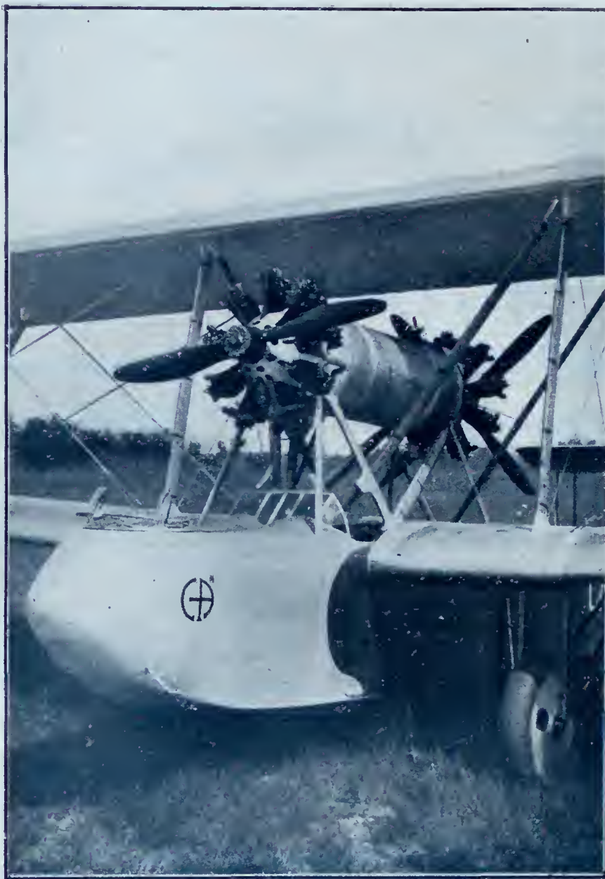
Il castello motore reggente i due Jupiter e, fra questi, il serbatoio della benzina.
